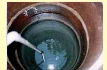
井側の井戸 (Pt.C) 井戸側壁がコンクリート壁で覆われたもの
